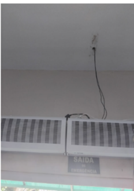
Manutenção fios cortina de ar da recepção
