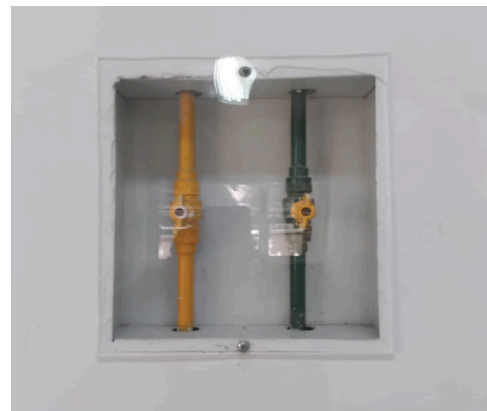
Instalação de proteção na régua de gases do corredor
