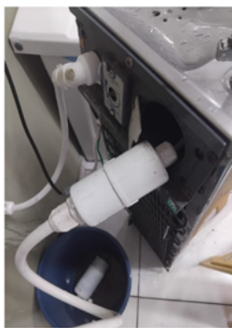
Manutenção e troca dos filtros de todos os bebedouros
