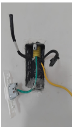
Manutenção tomadas emergência
