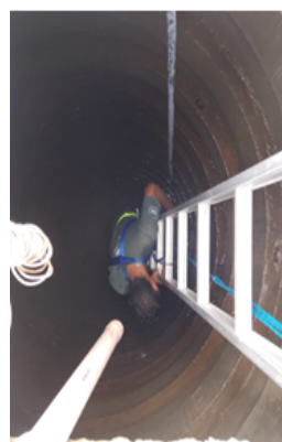
Limpeza caixa d'água
