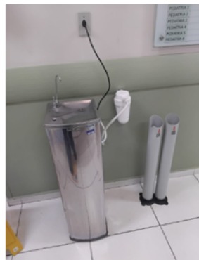
Manutenção e troca dos filtros de todos os bebedouros
