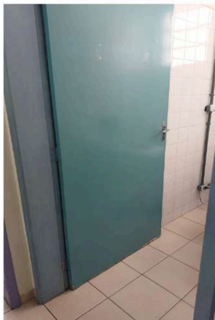
Reparo de porta
