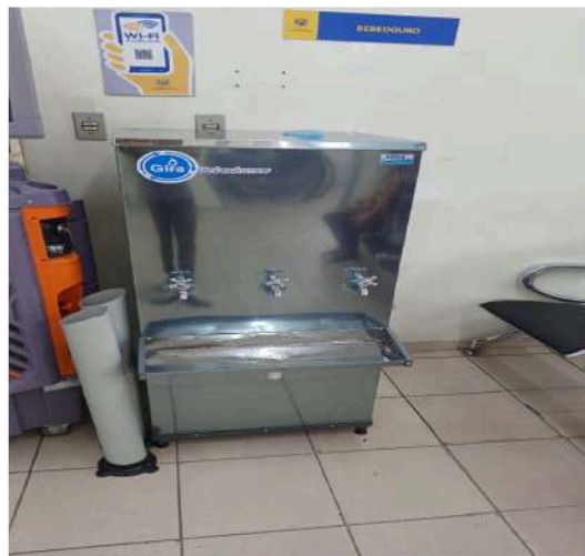
Instalação do novo bebedouro
