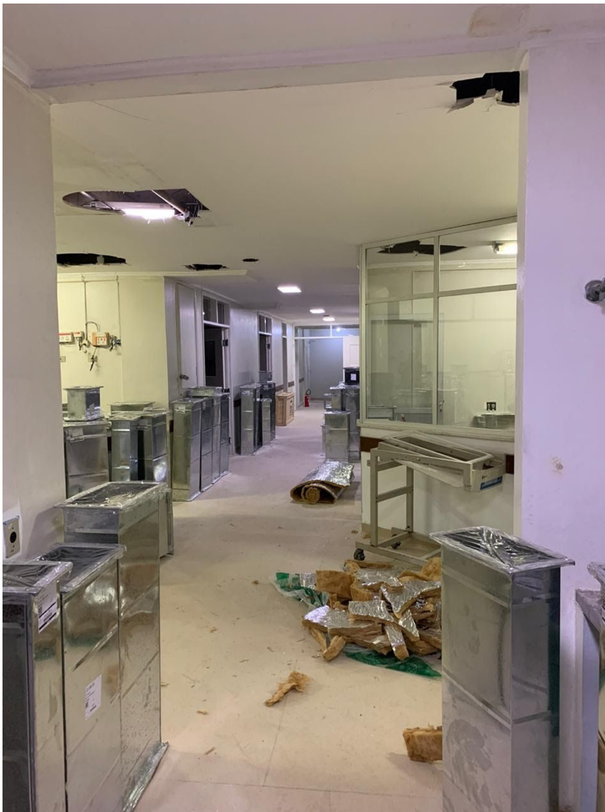
Obra com previsão de finalização em Fevereiro.
