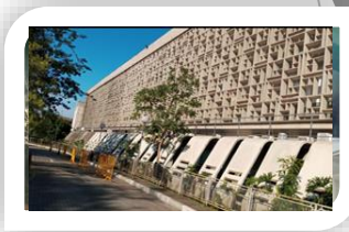
Retrofit Fachada e Gradil
