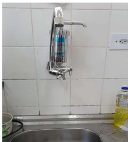
Copa de funcionários: instalação de torneira com filtro
