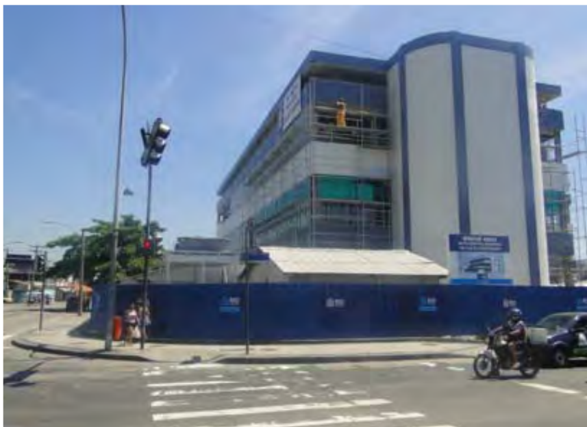
Foto: Obras - Maio 2012
