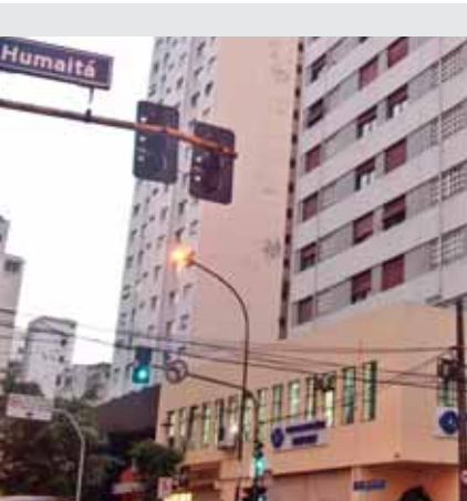
Fachada e localização
