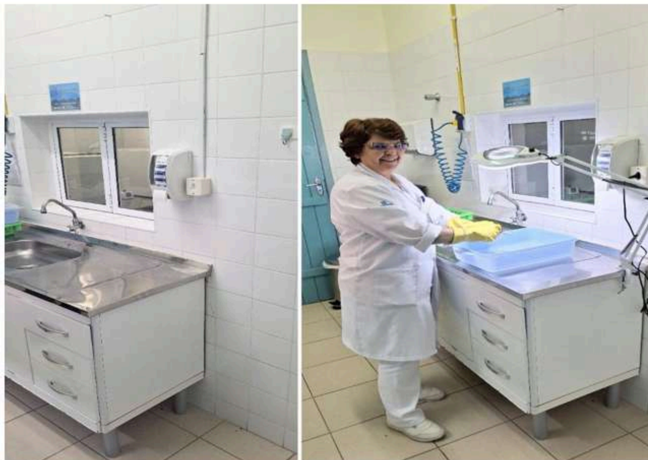
CME : Instalação de Lupa na área suja
