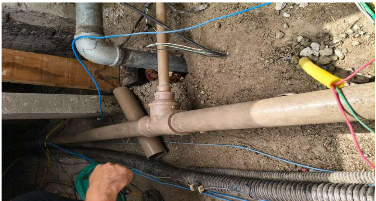
Troca de cano da tubulação acima telhado
