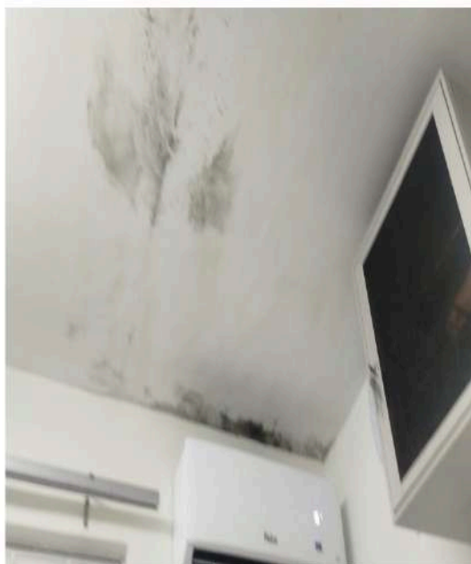
Correção da infiltração e pintura do teto – Sala Gerência , Sala 4 e Hipodermia
