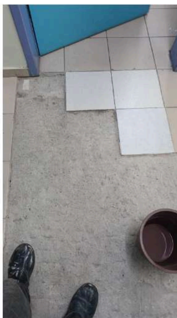
Rejunte do piso com sinais de estufamento
