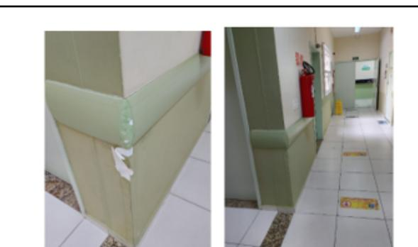
**Pintura e manutenção barra de proteção**
