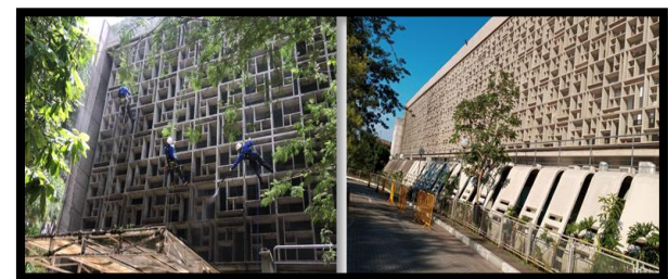
Limpeza da Fachada / Linha de Vida
