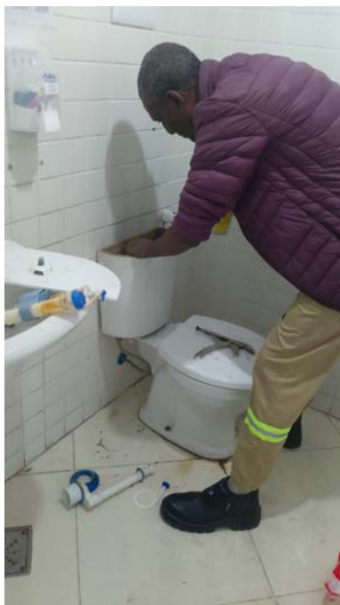
Troca do sistema da caixa acoplada do sanitário.
