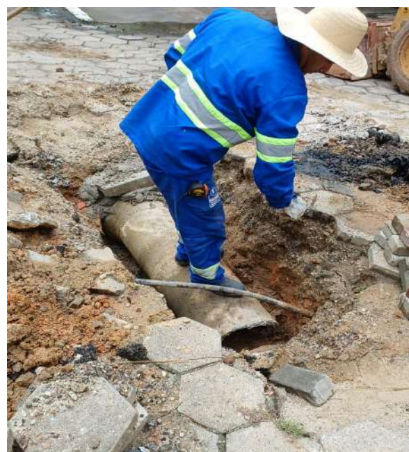
Reparo na manilha de esgoto
