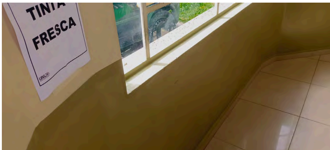
Pintura dos barramentos da unidade.
