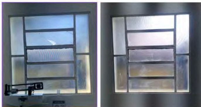
Troca de vidro quebrado
