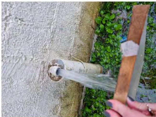
25/07/2025 - Furto da torneira externa/ Colocação de plug tampão
