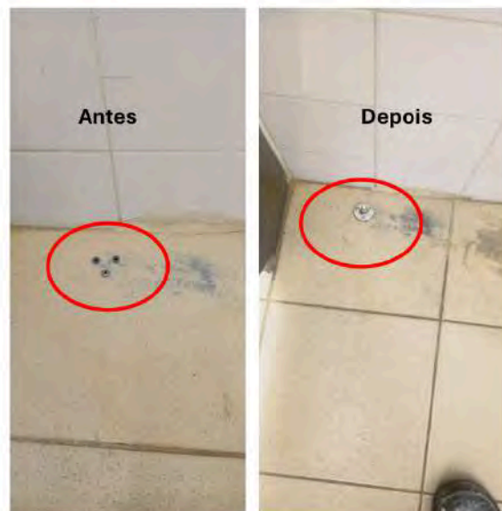
08/07/2025- Instalação de suporte de porta
