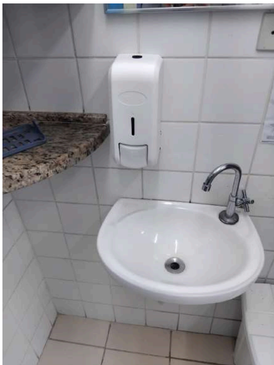
Instalação dos Dispensers
