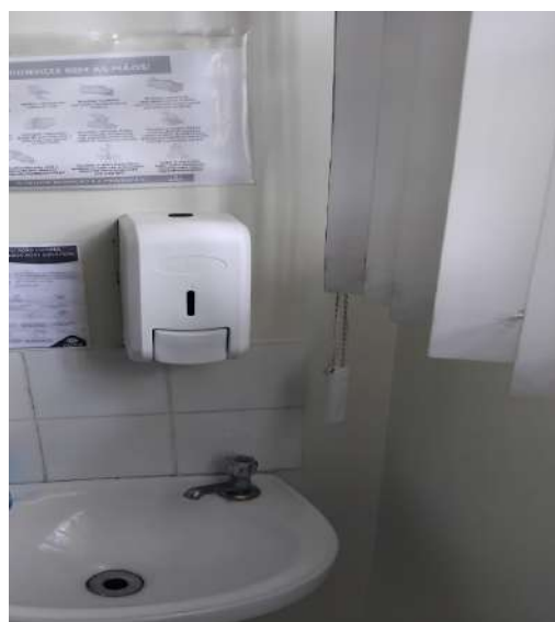
Instalação dos novos Dispensers nos Setores
