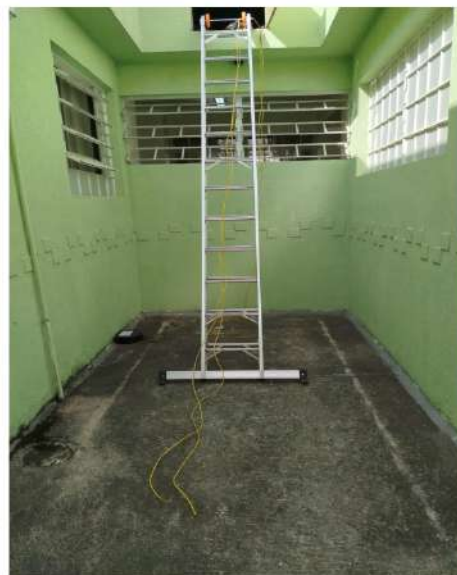
16/07/2025 – Furto de Fiação Troca de Fiação do Ar condicionado.
