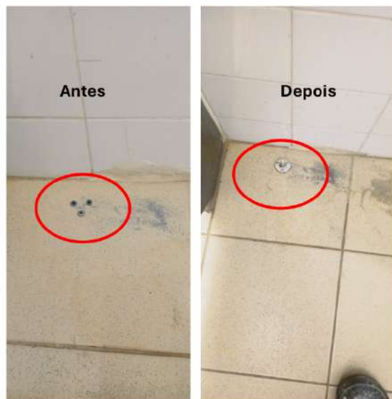
08/07/2025- Instalação de suporte de porta
