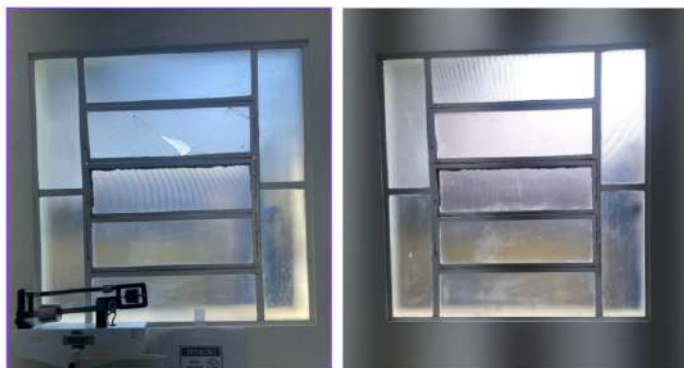
Troca de vidro quebrado
