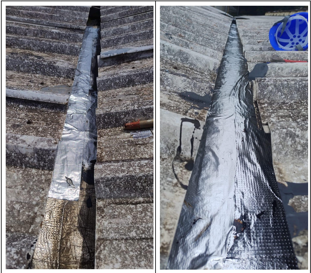
Manutenção preventiva no telhado
