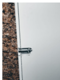
Trocas dos trincos das portas dos banheiros
