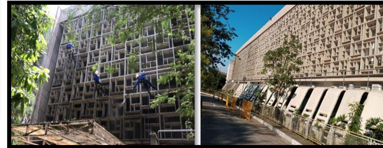
Limpeza da Fachada / Linha de Vida
