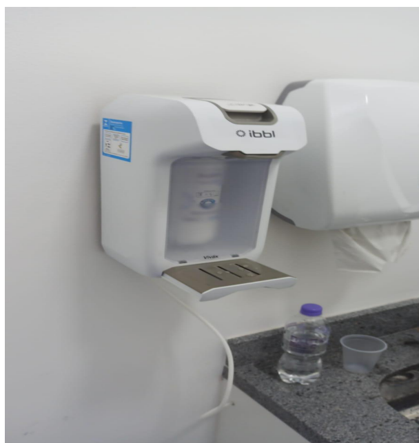
Instalação de filtro na copa
