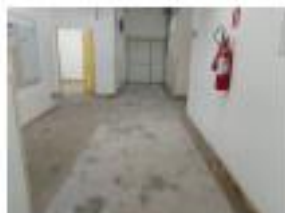
Piso removido no corredor em direção a UTI A e B.
