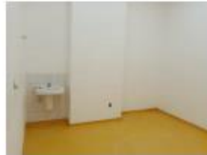
Consultório 3 com aplicação de piso.
