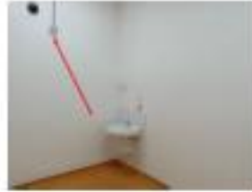
Infraestrutura de eletricidade por tubulação externa dever ser embutidos.
