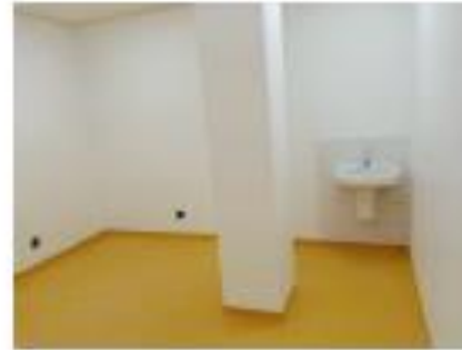
Consultório 4 com aplicação de piso.
