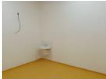
Piso aplicado no corredor de acesso ao Ambulatório de egressos, restando apenas serviço de solda.
