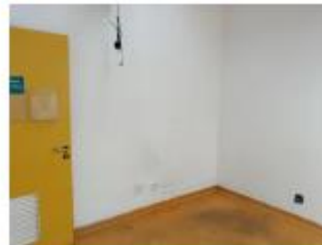
Piso bem danificado e as trincas nas paredes dos consultório e espelhos e tomadas faltantes.
