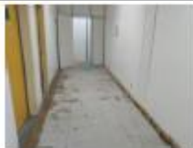
Remoção de piso no corredor atrás da recepção de Internação.
