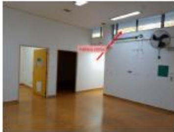
Salão central do ambulatório, pisos danificados, paredes com muitos buracos e faltando vidros nas janelas superiores.
