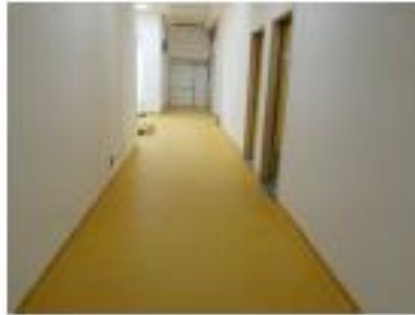
Piso aplicado no corredor de acesso ao Ambulatório de egressos, restando apenas serviço de solda.
