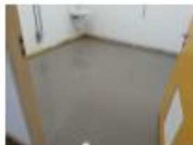
Aplicação autonivelante no 1º consultório lado direito da entrada do ambulatório.
