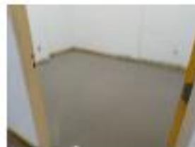
Aplicação de auto nivelante no 1º consultório lado esquerdo da entrada do ambulatório.
