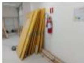
Remoção de portas de madeira e guarnições.
