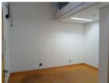
2º Consultório lado esquerdo da entrada do ambulatório.
