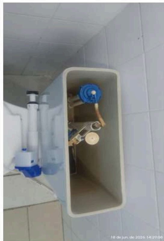
Substituição da Caixa Acoplada da Descarga.
