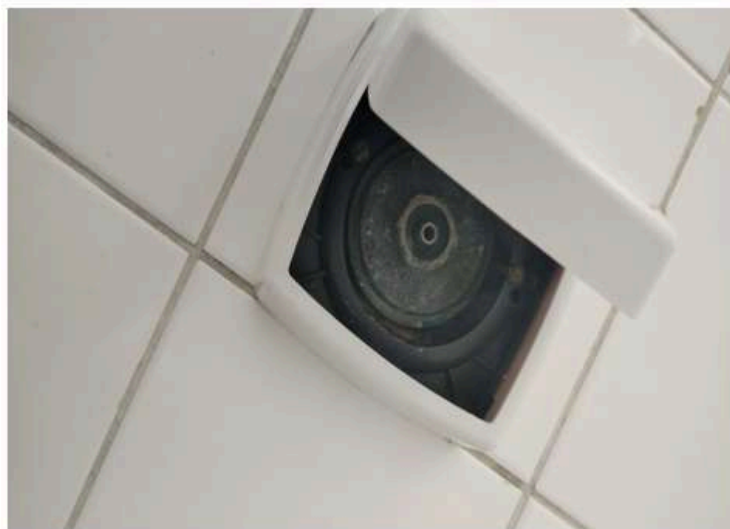
Substituição do Botão de Acionamento da Descarga
