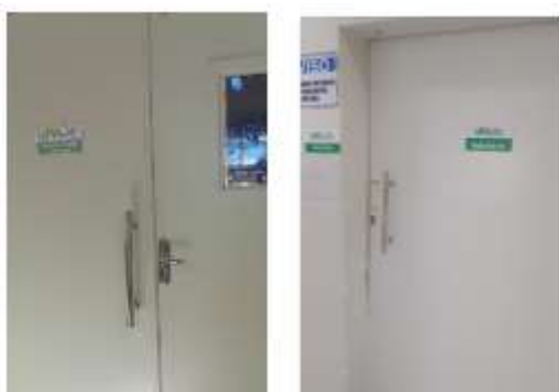
Instalação puxador nas portas
