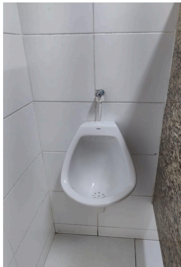
Instalação de novos mictórios dos banheiros masculinos
