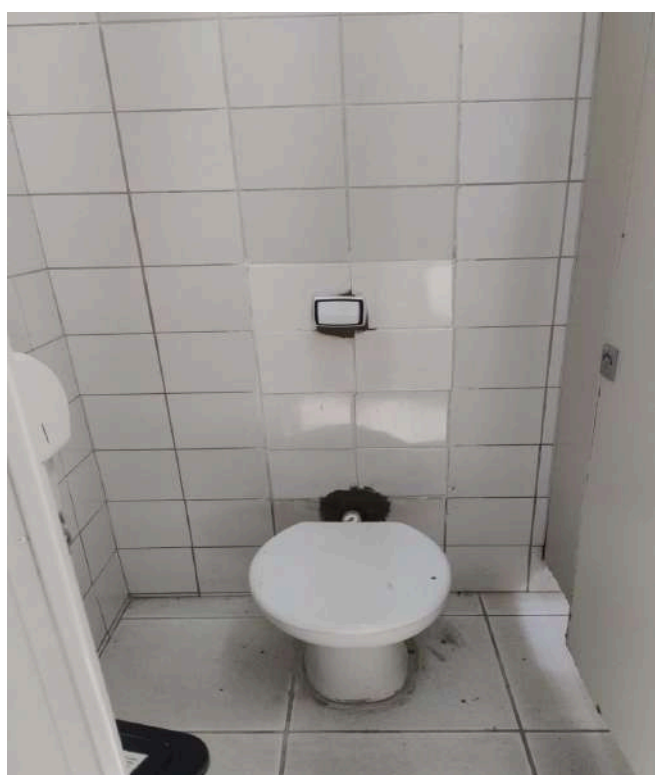
Troca de acionador de descarga
