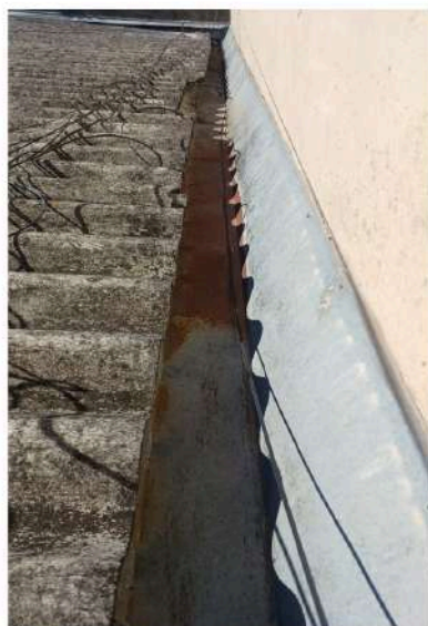
Limpeza de calhas
