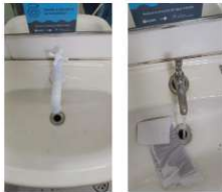
Troca das torneiras vestiário
