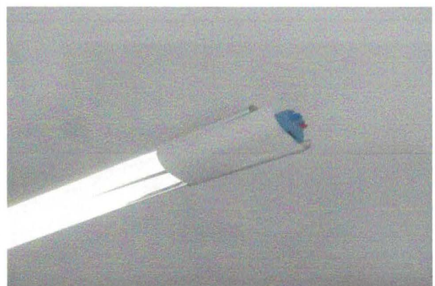
Figura 25 – Luminária Danificada
