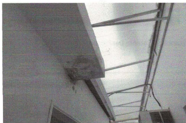
Figura 18 – Infiltração corredor
