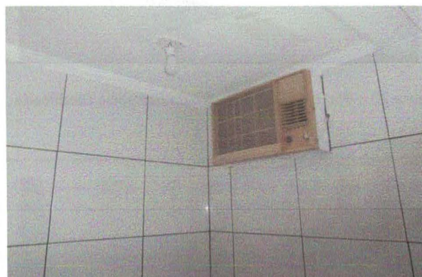
Figura 19 – Iluminação Inadequada sala de Odontologia
