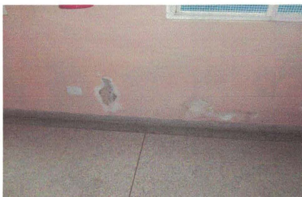
Figura 14 – Infiltração Paredes
