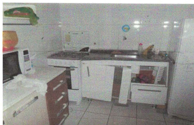
Figura 26 – Gabinete da Cozinha Destruído
