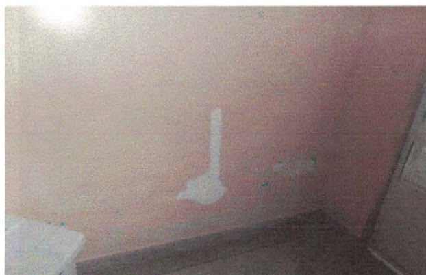
Figura 13 – Infiltração Paredes
