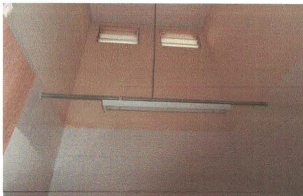
Figura 25 – Luminárias sem Lampâdas
