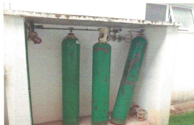
Figura 27 – Abrigo de Cilindros sem Porta e sem Corrente para Ancoragem
