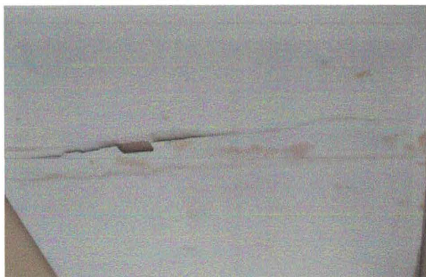
Figura 16 – Infiltração Forro
