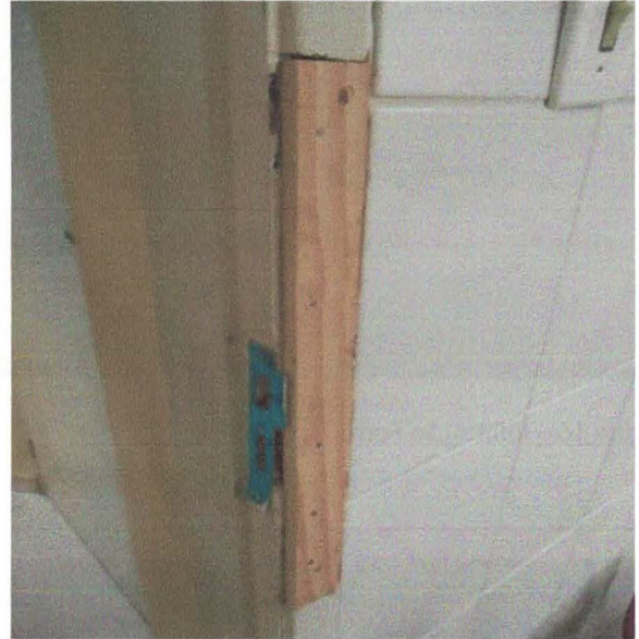
Figura 21 – Batente Danificado
