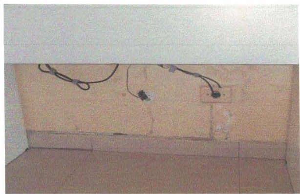
Figura 27 – Fiação Exposta
