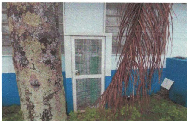
Figura 03 – Abrigo de Gases
