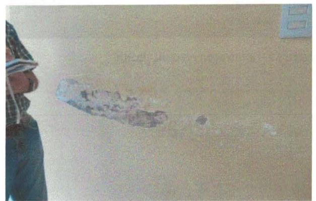
Figura 15 – Infiltração Corredor
