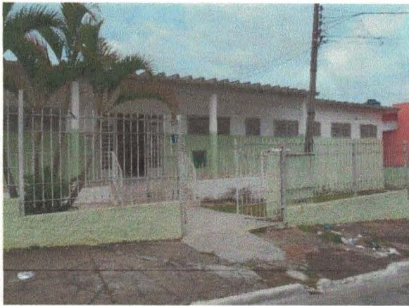
Figura 01 – Fachada do prédio
