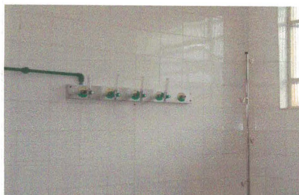
Figura 10 – régua de gases
